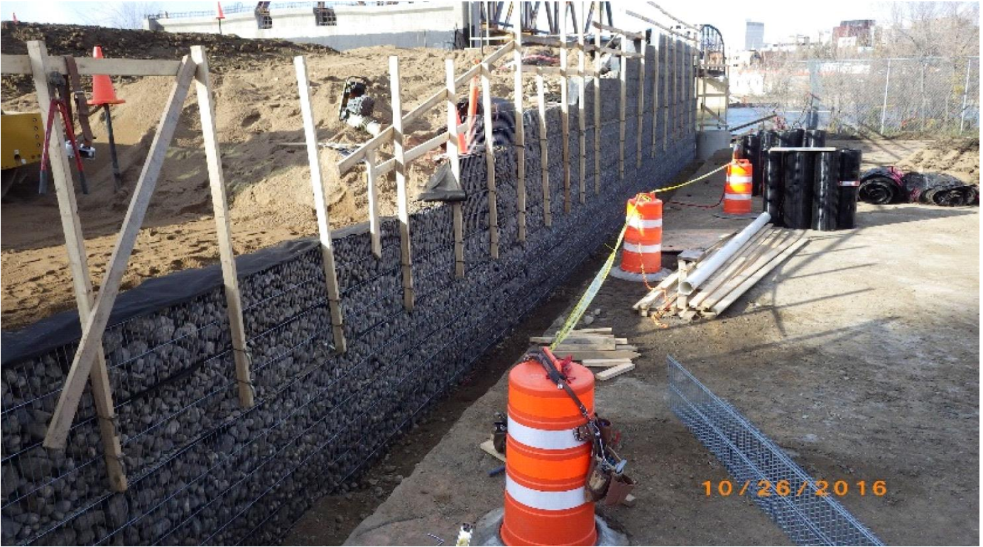
TB MSE Wall Construction
